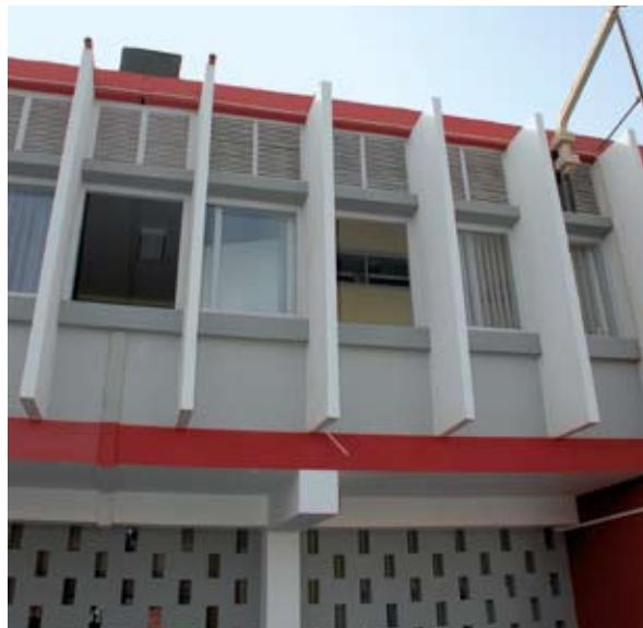
{ FIG. 1.53 } Edifício modernista na cidade da Praia, com aberturas de fachada para ventilação a vários níveis: superior, para renovação de ar e arrefecimento da massa do edifício; e inferior (janelas) para o conforto dos ocupantes. As necessidades de ventilação natural e sombreamento foram factores considerados do projecto do edifício, o que é bem visível na tipologia da fachada.
