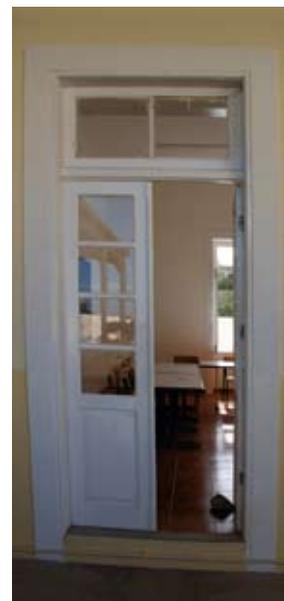
{ FIG. 1.54 } Interior de uma escola no Mindelo. (1): Os vãos interiores têm uma altura generosa permitindo o fluxo de ventilação a nível superior, além de contribuírem para um bom desempenho em termos de iluminação natural. (2): janelas abertas para ventilação natural, quando a temperatura exterior é confortável durante o dia.
