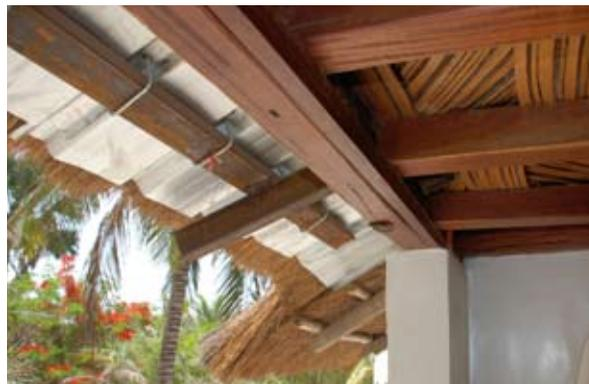
{ FIG. 1.45 (1 e 2) } Sistema construtivo misto de cobertura. O colmo é sobreposto em chapa corrugada de material metálico (sub-capa): aos benefícios da impermeabilização e durabilidade conferidos pelo uso da sub-capa metálica adiciona-se a capacidade isolante do colmo.
