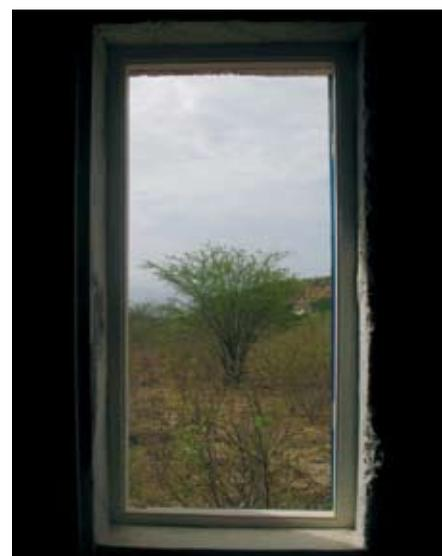
{ FIG. 1.50 } A disposição vertical das janelas é preferível à horizontal, pois evita problemas de desconforto luminoso (encadeamento e contraste) e apresenta vantagens em termos da disposição do mobiliário no interior. Permite também a ventilação a nível superior, para renovação de ar e arrefecimento da massa do edifício durante a noite.
