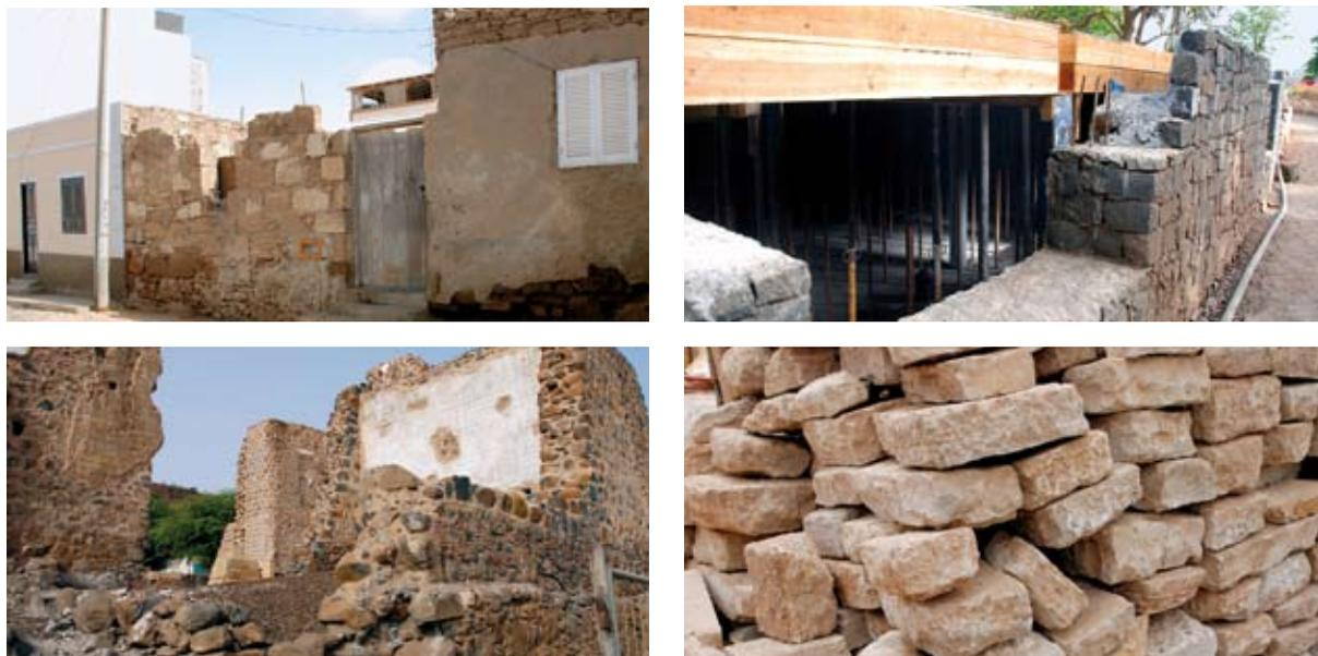
{ FIG. 2.2 } Uso tradicional (esquerda) e contemporâneo (direita) da pedra na construção de paredes exteriores.
