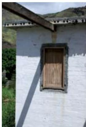
{ FIG. 6.12 } Fachada principal e aberturas nas lajes para ventilação.
