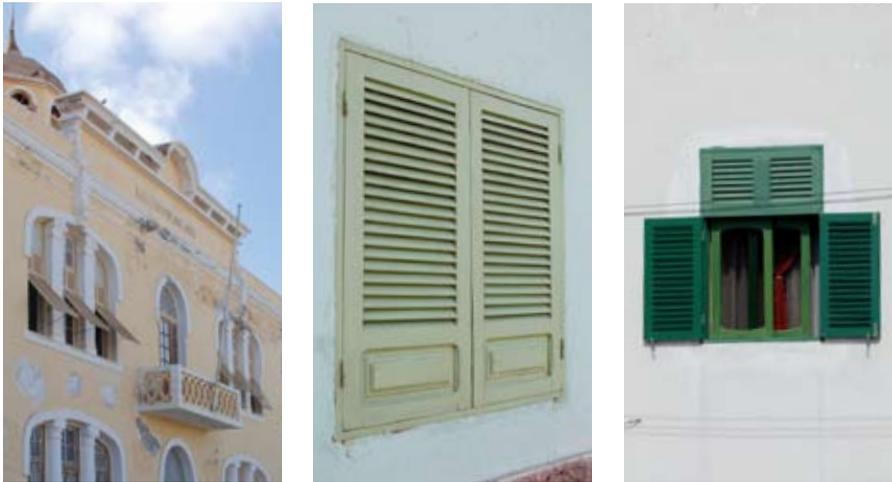
{ FIG. 1.32 } Sombreamento ajustável: portadas exteriores de madeira (venezianas): proporcionam sombreamento e simultaneamente permitem iluminação e ventilação natural.
