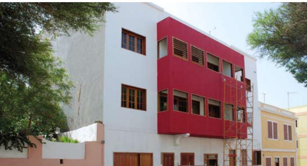
{ FIG. 1.28 } Sombreamento fixo: projecção para sombreamento das varandas e envolvente opaca num edifício em construção na cidade do Mindelo.
