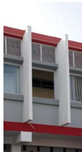
{ FIG. 1.24 } Utilização de palas verticais fixas, num edifício da cidade da Praia, para sombreamento da área de envidraçado e envolvente opaca. De notar também a articulação com a necessidade de ventilação natural.
