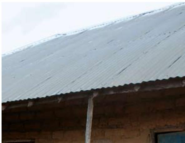
{ FIG. 1.45 (3) } O uso sem protecção (isolamento) de material metálico para coberturas deve ser evitado, dado que leva ao agravamento de situações de sobreaquecimento interno.
