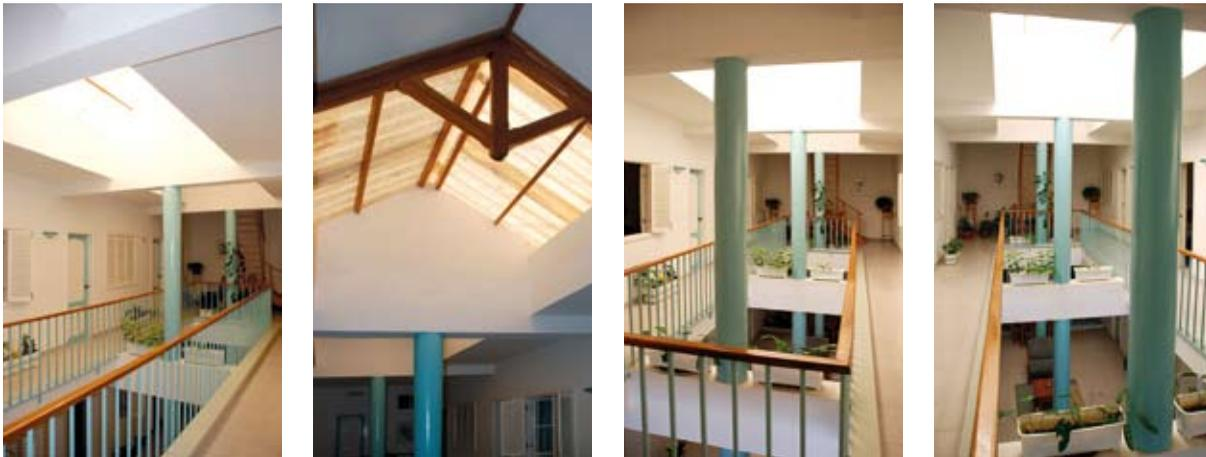
{ FIG. 1.63 (1-4) } Átrio interior num edifício na cidade da praia. Promove iluminação natural e ventilação do interior por efeito de chaminé. Em climas quentes como em Cabo Verde, o topo do átrio deve estar pelo menos 5m acima do espaço do último piso ocupado, e deve ter aberturas para ventilação, por forma a evitar a acumulação de ar quente.
