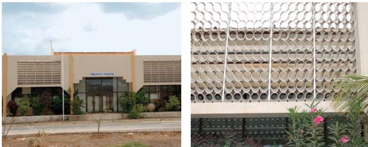
{ FIG. 1.30 } Sombreamento fixo: sistema de sombreamento de fachada dupla, num edifício institucional na cidade da Praia. O pano de fachada exterior sombrea a área de envidraçado e envoltivo opaca através da utilização de um engenhoso sistema de grelha utilizando tubos sobrepostos, permitindo a entrada de luz e ventilação natural.
