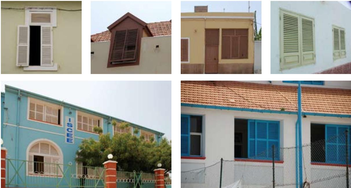
{ FIG. 1.51 (2-7) } As portadas exteriores venezianas são uma tipologia tradicionalmente usada em Cabo Verde. Permitem o sombreamento dos vãos, e simultaneamente a ventilação natural do interior do edifício.
