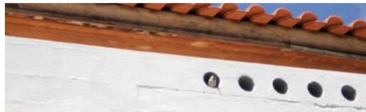
{ FIG. 1.57 } Aberturas a nível superior para remoção do ar quente.
