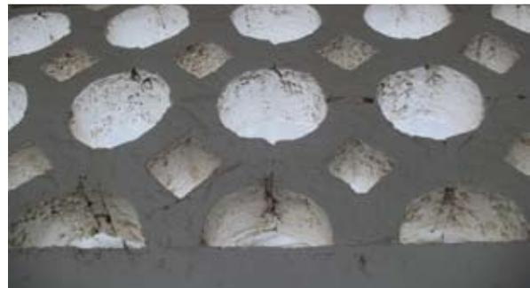
{ FIG. 6.6 } Vista da entrada do Sítio Museológico de Lajedos e de uma parede com aberturas em grelha para ventilação e iluminação.
