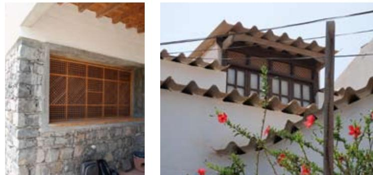
{ FIG. 1.52 } O uso de grelhas fixas, apesar de não permitir ajustamentos para controle do sombreamento e do fluxo de ventilação, também pode ser eficaz.
