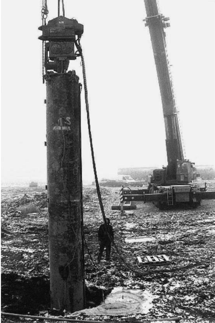
Figure 10.23 Extracted column. (From Axelsson, M. (2001). Djupstabilisering med Kalkcementpelare-Metoder för Produktionsmassig Kvalitetskontroll i Fält (Deep Stabilization with Lime Cement Columns – Methods for Quality Control in the Field) , Report No. 8. Linköping, Sweden: Swedish Deep Stabilization Research Centre.)
