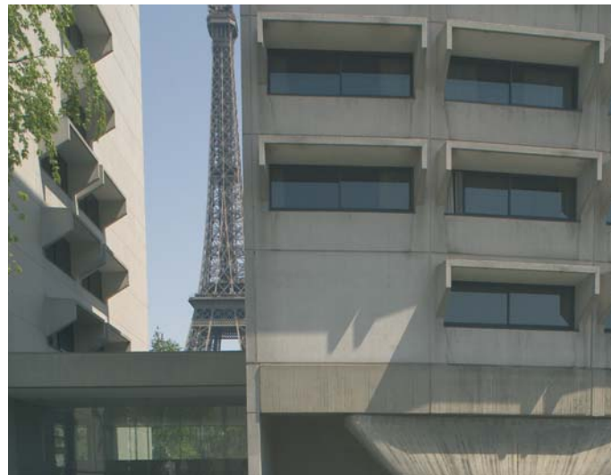
Prefabricated Concrete Façade Panels of the Australian Embassy Panneaux de façade préfabriqués de l'Ambassade d'Australie Harry Seidler Paris, France 1978
