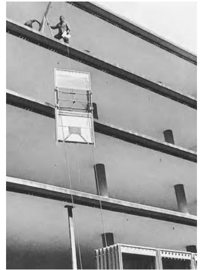
Assembly of Prefabricated Façade Panels of the Fédération du Bâtiment Assemblage des panneaux de façade pré- fabriqués de la Fédération du Bâtiment
