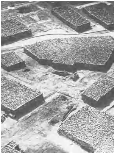
After Firebombing and Cleanup Après l'incendie et le déblaiement Saint-Dié-des-Vosges, France 1945
