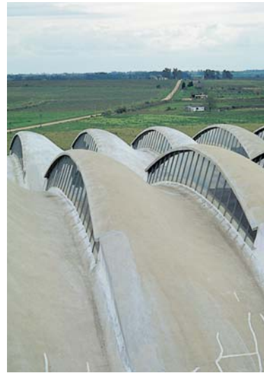
Warehouse for Lanús A.D.F. Entrepôt pour Lanús A.D.F. Eladio Dieste Canelones, Uruguay 1994
