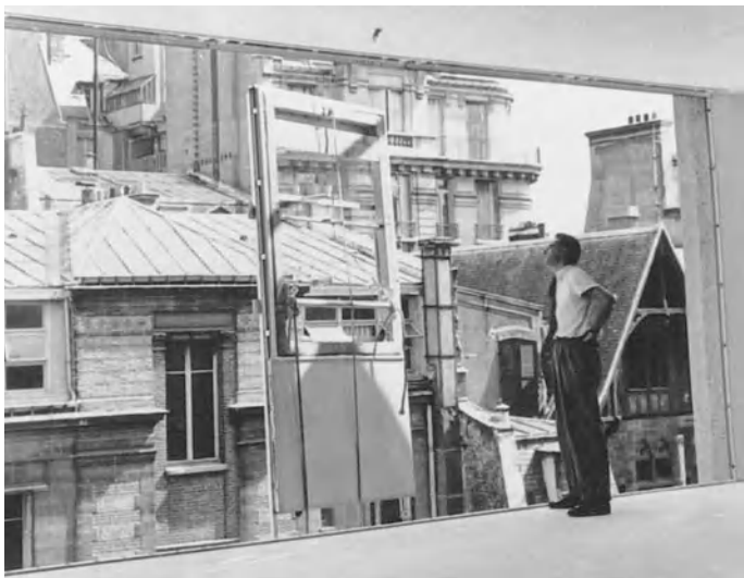
Assembly of Prefabricated Façade Panels of the Fédération du Bâtiment Assemblage des panneaux de façade pré- fabriqués de la Fédération du Bâtiment Jean Prouvé, Gravereaux et Lopez Paris, France 1949
