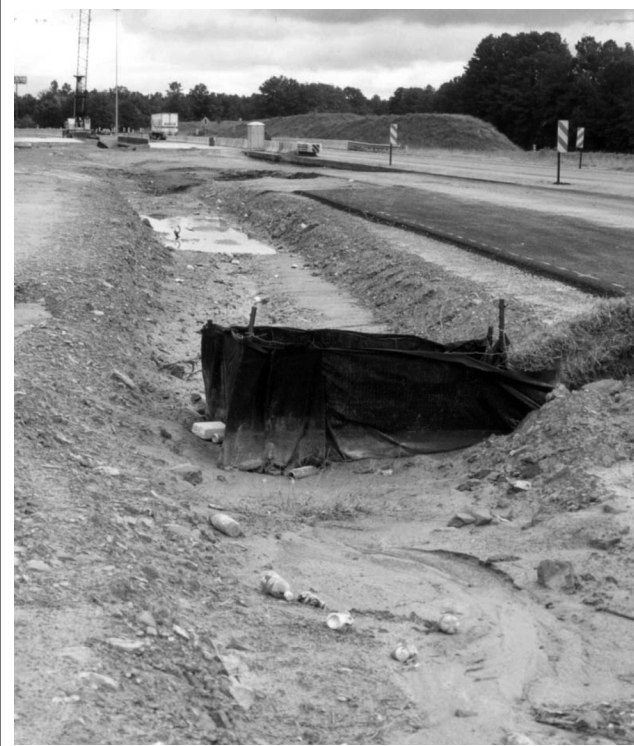
Typical filter fabric enclosure surrounding inlet (J. Voorhees photo).
