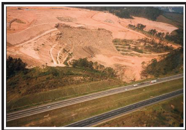
FIG. 1. Landfill accident (1991). Photos: Kaimoto, L.S.A. (2006)
