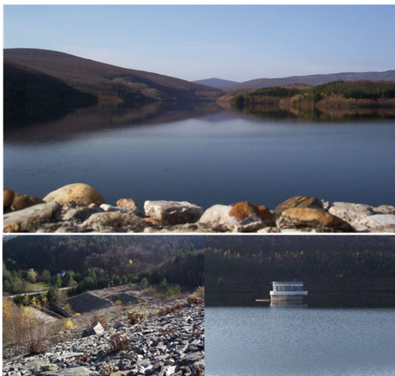
Fig. 3 Water reservoir Bukovec II (photo: M. Zeleňáková)
