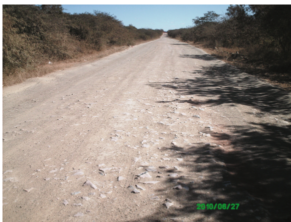
Fig. 8. Excerpt from Manga-São João das Missões. Observe typical rocky material in the surface layer.
